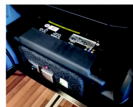
Montage de la batterie 12V et 220 V
